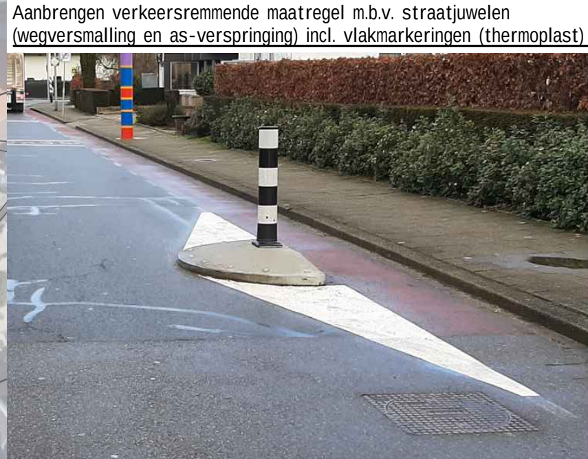
Aanbrengen verkeersremmende maatregel m.b.v. straatjuwelen (wegversmalling en as-verspringing) incl. vlakmarkeringen (thermoplast)
