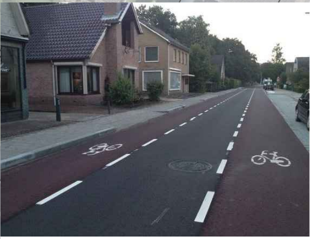
Aanbrengen fietsstrook (breedte = 2,00m) Uitvoering in rode coating inclusief fietssymbolen en onderbroken lengtemarkering 1-1 van thermoplast
