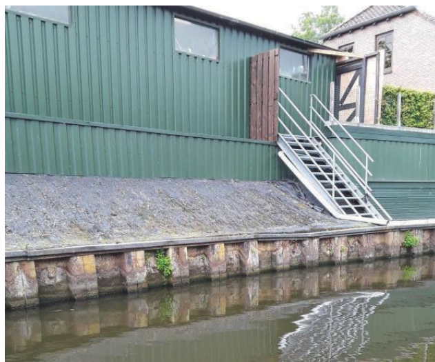
Figuur 12: Geometrie bestaande damwandconstructie
