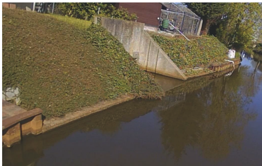
Figuur 20: Situatie huidige damwandconstructie
