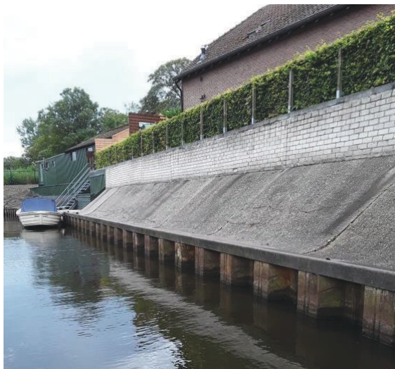
Figuur 22: Situatie bestaande damwandconstructie
