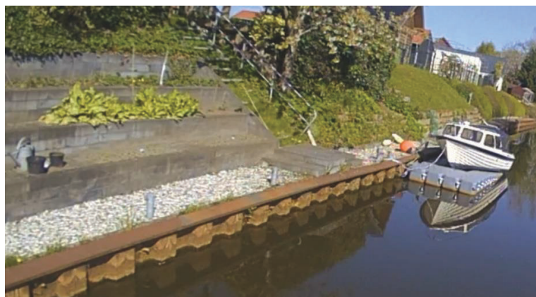
Figuur 19: Situatie huidige damwandconstructie
