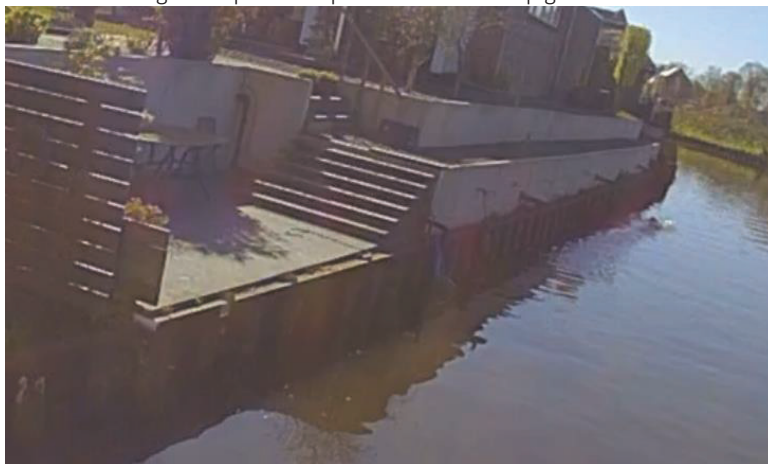
Figuur 15: Situatie huidige damwandconstructie
