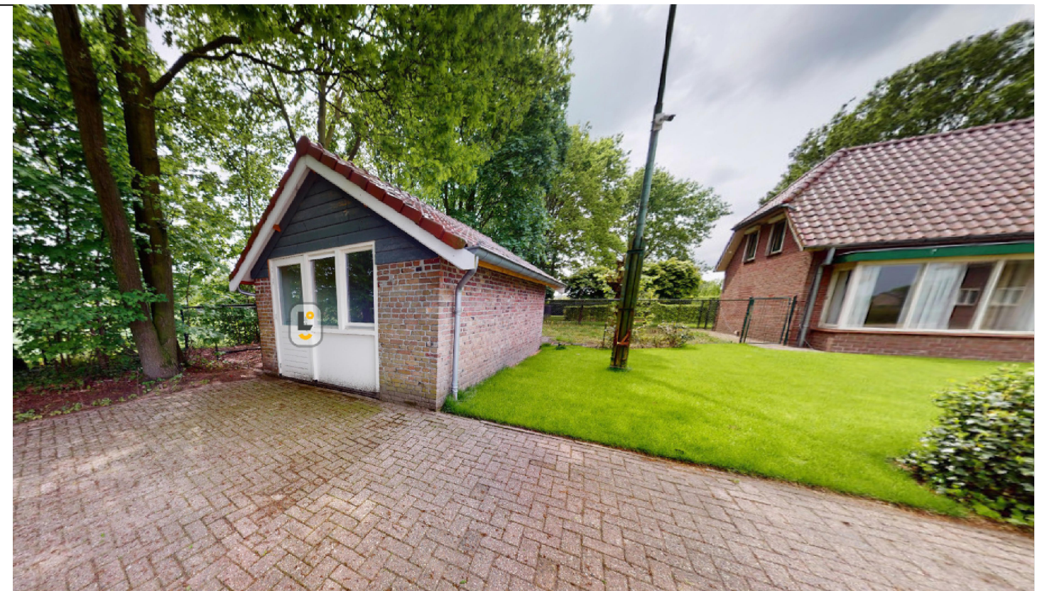
Foto bestaande situatie
