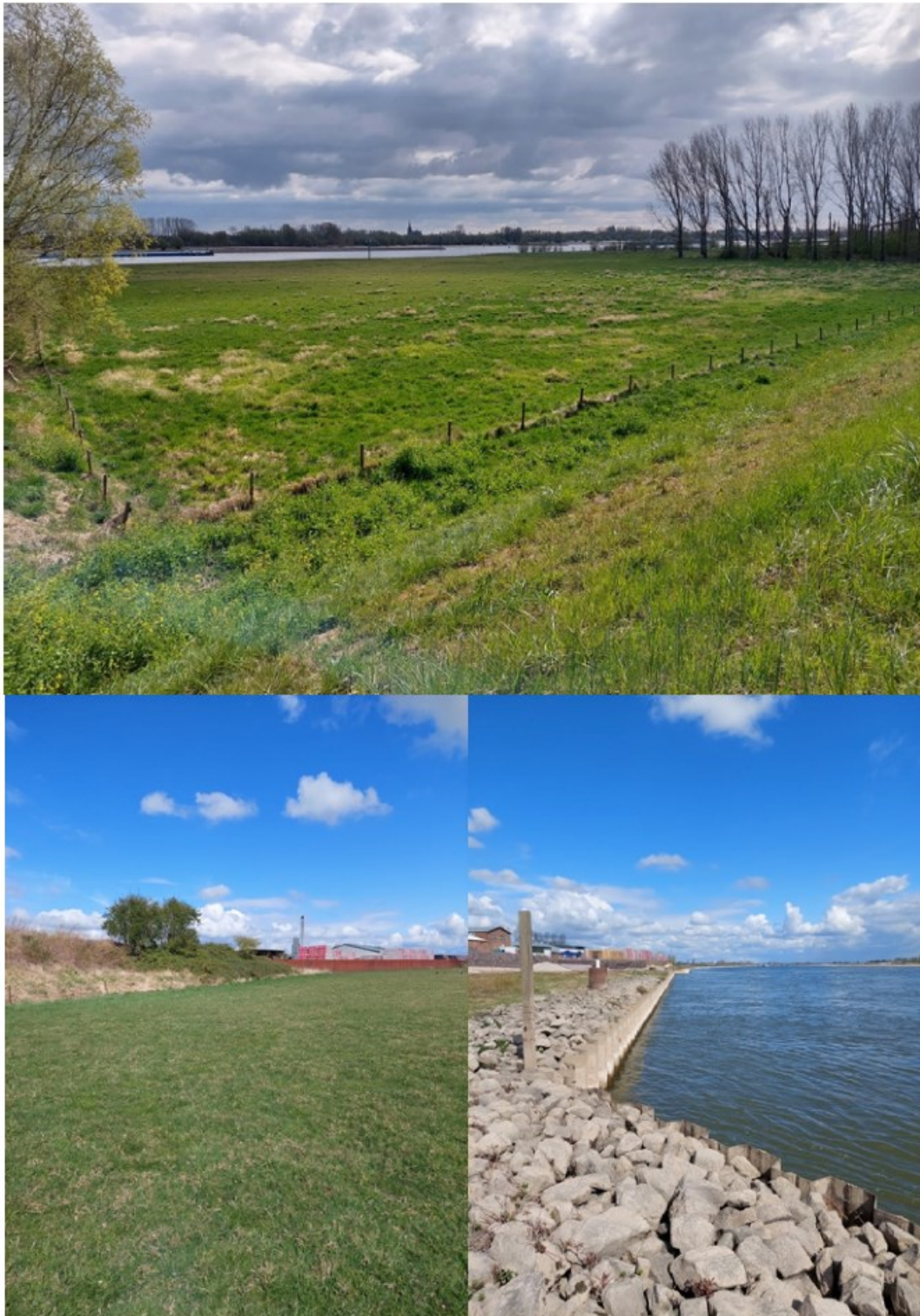
Figuur 2.2 Impressie deellocatie 2. Foto boven: depotlocatie. Foto linksonder: locatie transportroute. Foto rechtsonder: oever met stalen oeverbeschoeiing, waarlangs ponton geplaatst wordt.
