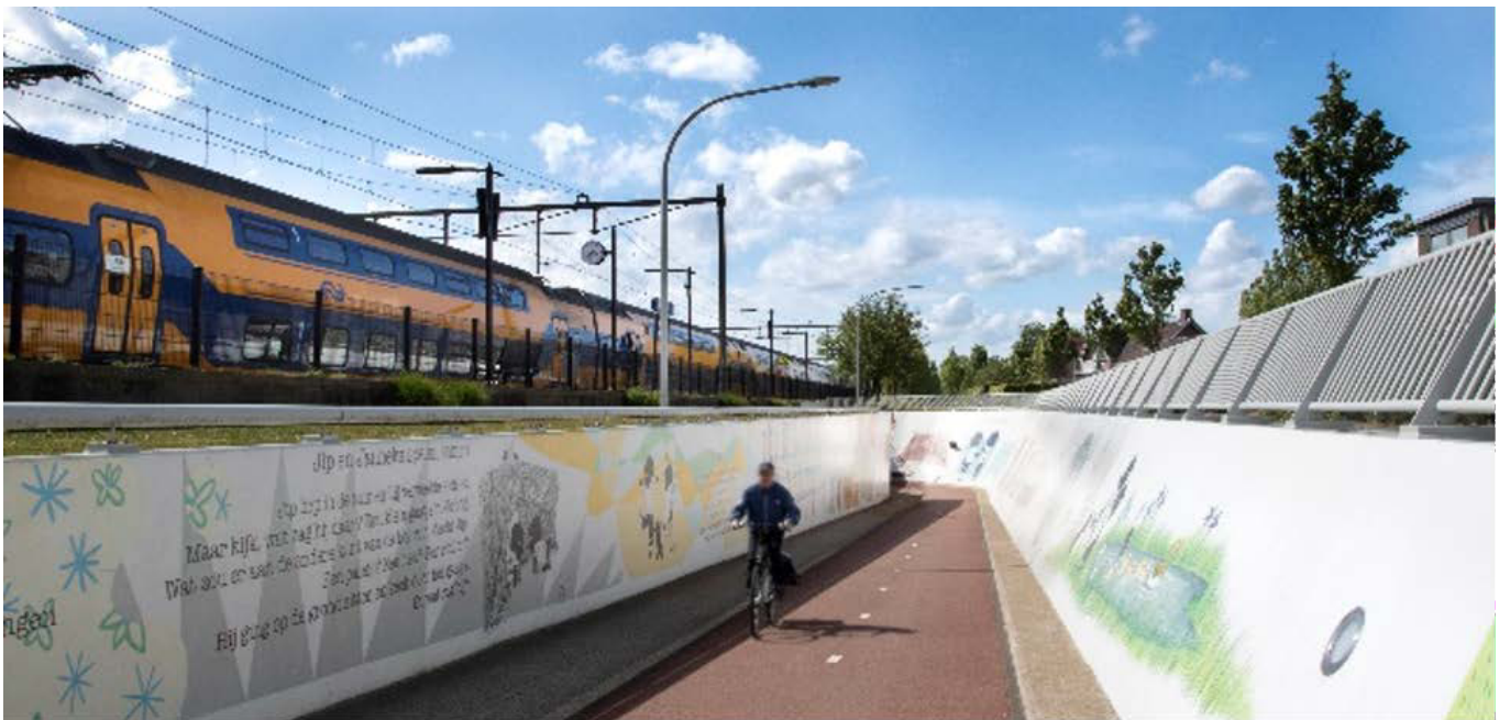
Figuur 10 Fietstunnel Kapelle
