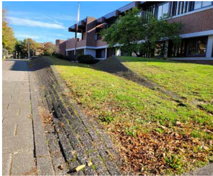
< Bestaande kunstwerk aan de Groenewoudseweg
