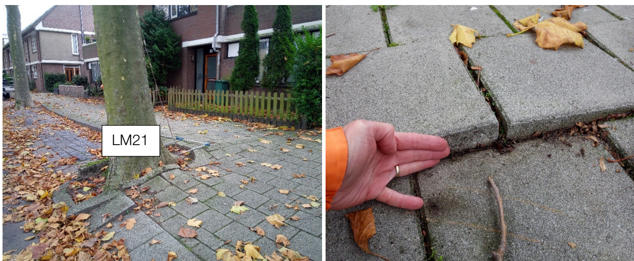
Foto 1. Links: Zeer ernstige opdruk bij plataan LM21 (huisnr. 16). Rechts matige opdruk van tegels (2-5 cm) in vak E.
