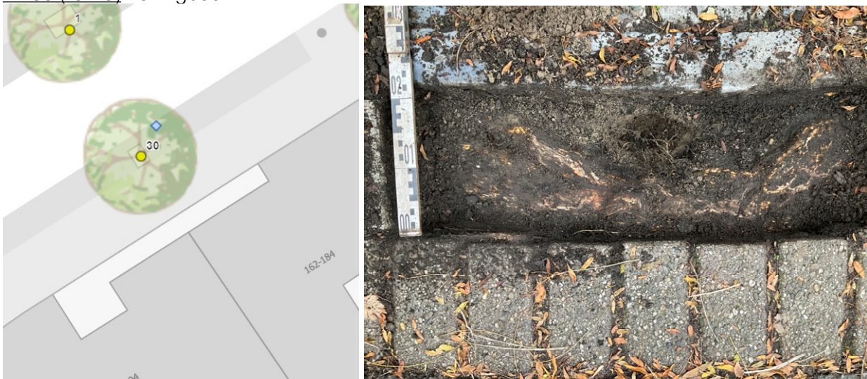
Foto 10. Links: graaflocatie bij blauwe hokje (in parkeervak). Rechts: in het parkeervak worden klinkers 5-10 cm omhoog gedrukt door gestelwortels van 8-10 cm doorsnee. Opdrukklasse: ernstig. De voegen van de klinkers zijn ruim: 4-6 mm, en gevuld met bladresten, hierdoor zwart gekleurd. Onder de klinkers is een laagje zwarte grond ontstaan op het gele duinzand. Er zijn regenwormen actief onder de klinkers. De boom neemt de voedingsstoffen uit de verterende bladmassa op door oppervlakkig en over grote lengte wortels te maken direct onder de verharding.
