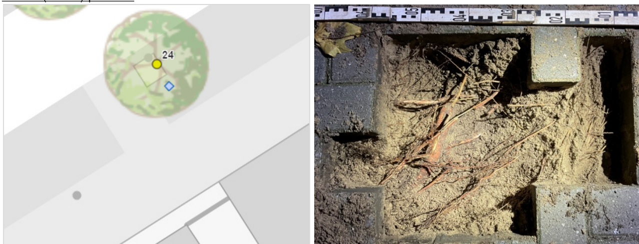
Foto 7. Links: graaflocatie bij blauwe hokje. LM24 is een plataan. Hier is in 2014-2015 opgehoogd met 15 cm. Rechts: wortels liggen nu hoog in het cunet en drukken tegels meer dan 2 cm omhoog (matige opdruk).
