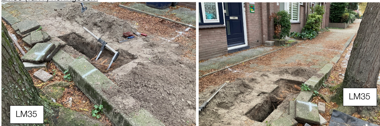
Foto 8. Links: graaflocatie honingboom LM35. Opdruk is >10 cm. Rechts: wortelbundel diameter 20x20 cm onder de opsluitband en hoog in het trottoir.
