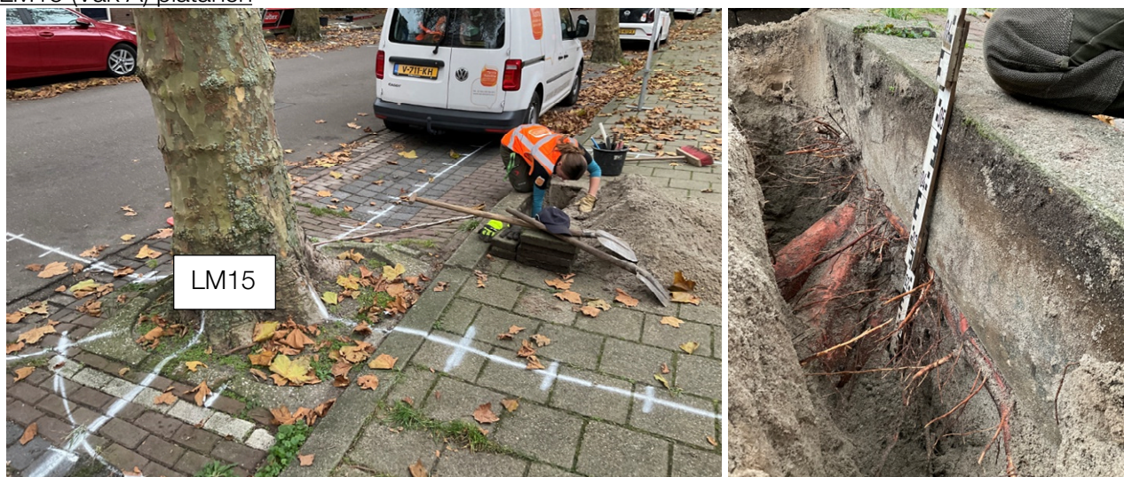
Foto 2. Links: graaflocatie bij plataan LM15 (voor huisnr. 21). Rechts: gestelwortels van de plataan drukken de trottoirband matig omhoog.
