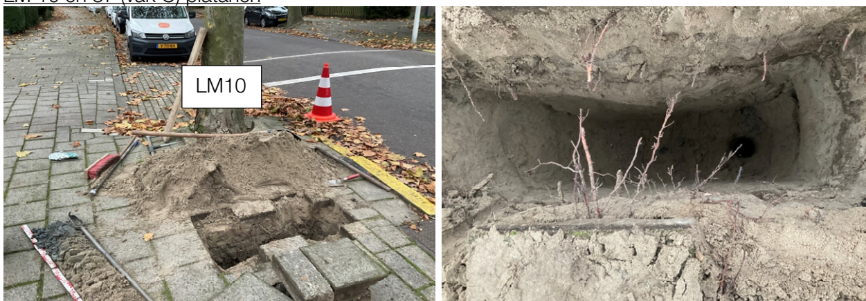
Foto 4. Links: graaflocatie bij plataan LM10 (nabij huisnr. 41). Rechts: alleen fijne wortels van de plataan aangetroffen, direct onder de verharding van het trottoir.
