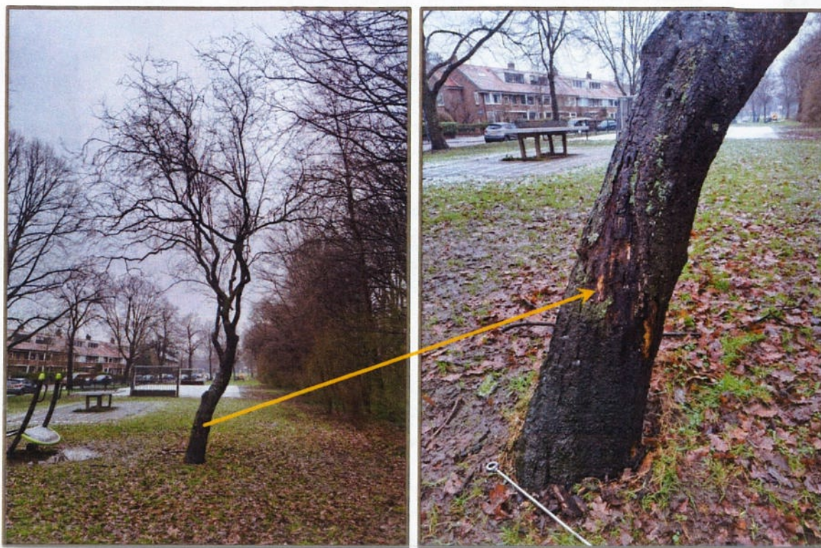
Fig. 1: De stambasis wordt door een houtparasitaire schimmel aangetast waardoor er houtrot ontstaat. De boom is afstervend en wordt in toenemende mate gevoelig voor windworp. Vanwege de speelvoorzieningen is het van belang om deze boom tijdig te kappen.
