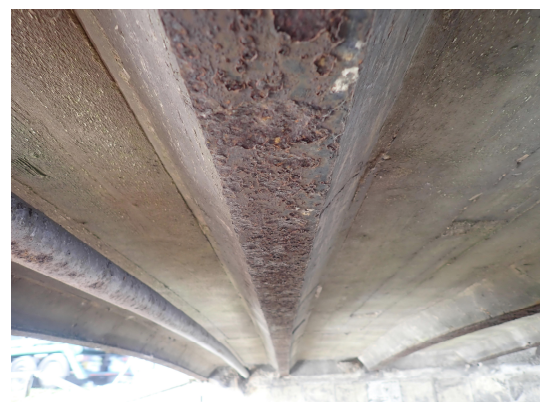
Gecorrodeerde ligger
