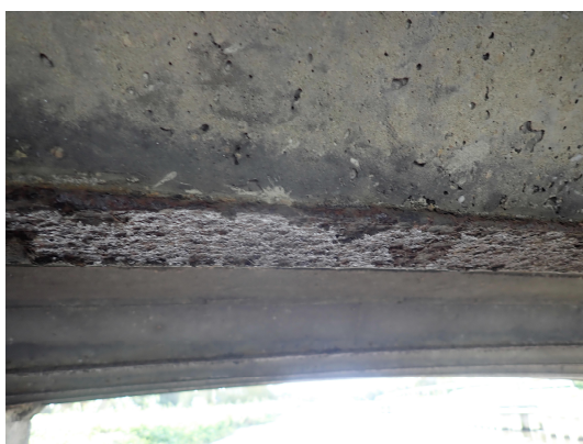
Gecorrodeerde ligger
