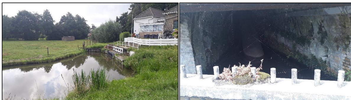
Afbeelding 5: Locatie gemaal (links) en detail foto ingang gemaal (rechts).
