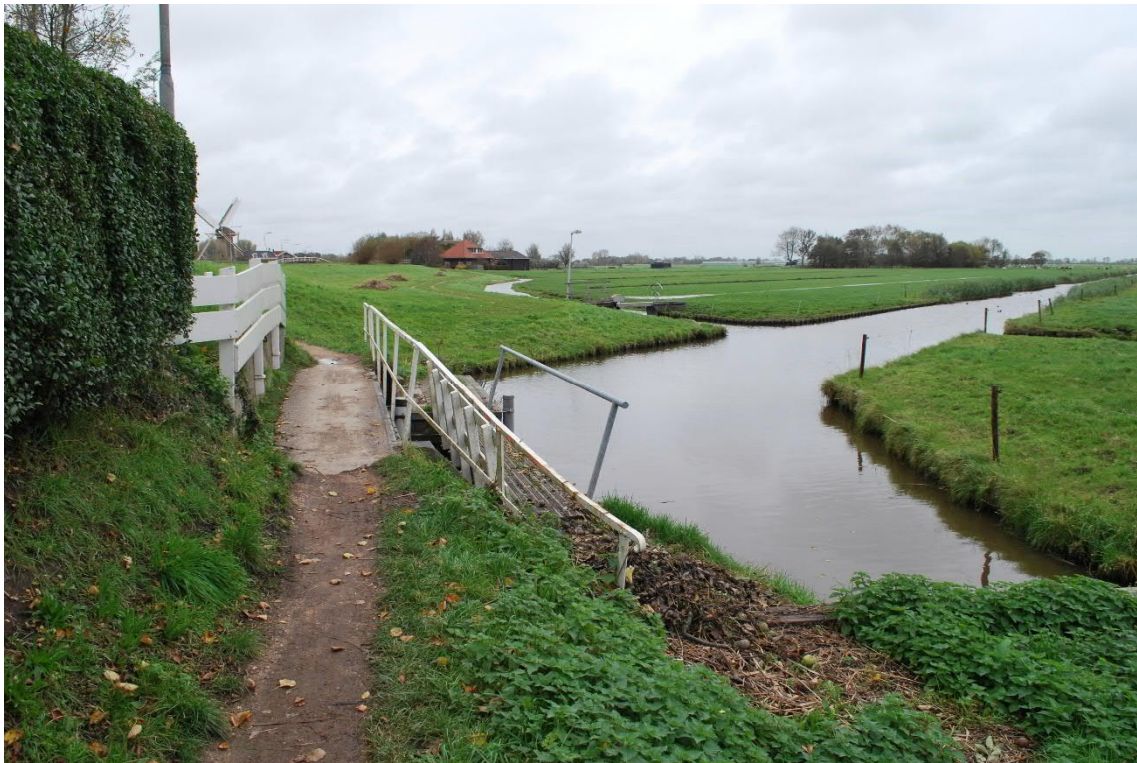
Foto 9: Commandeurspolder ter hoogte van gemaal (gezien vanuit zuidwest- in noordoostelijke richting)
