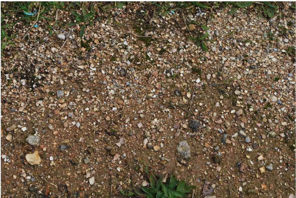
Foto 4: halfverharding van fijn gebroken puin op toegangspad naar stuw nabij Molenweg
