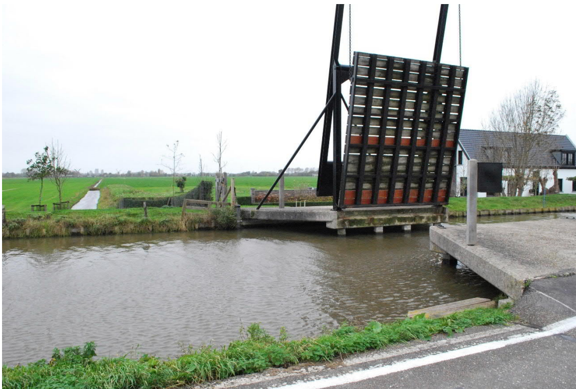
Foto 11: Ophaalbrug over Middelwatering (rechts woning Kwakelweg 18)
