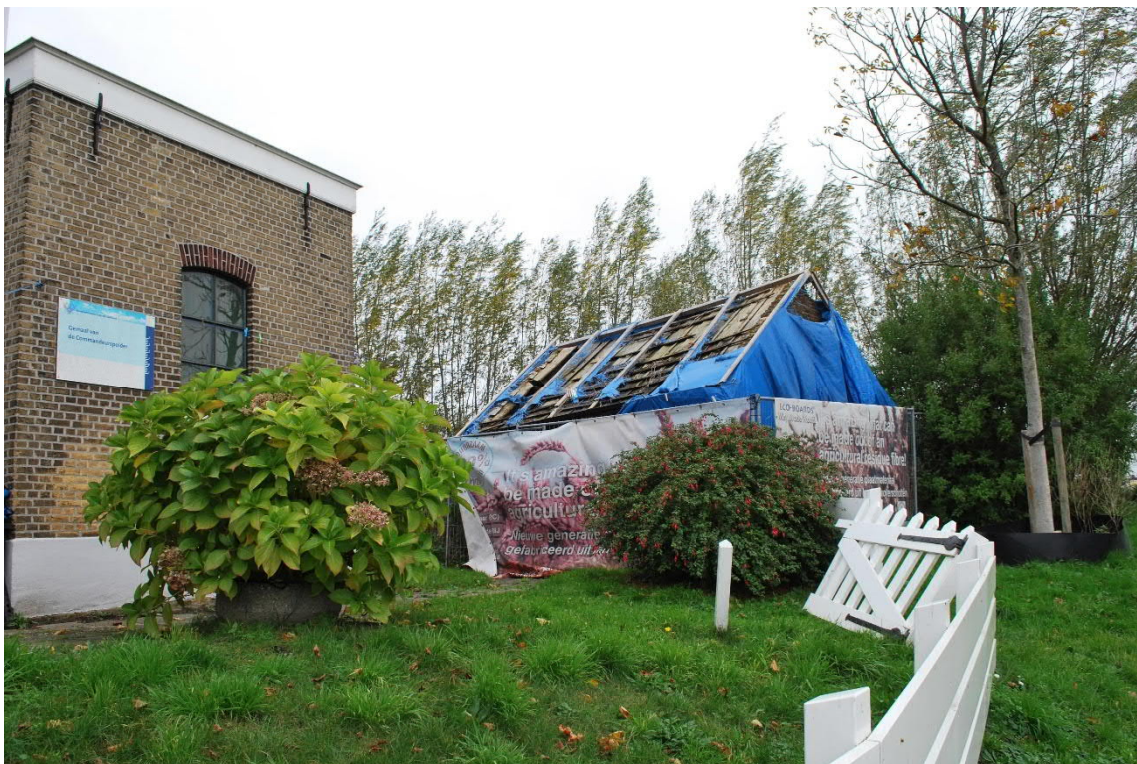
Foto 8: Ruïne van bakhuis naast bestaand gemaal
