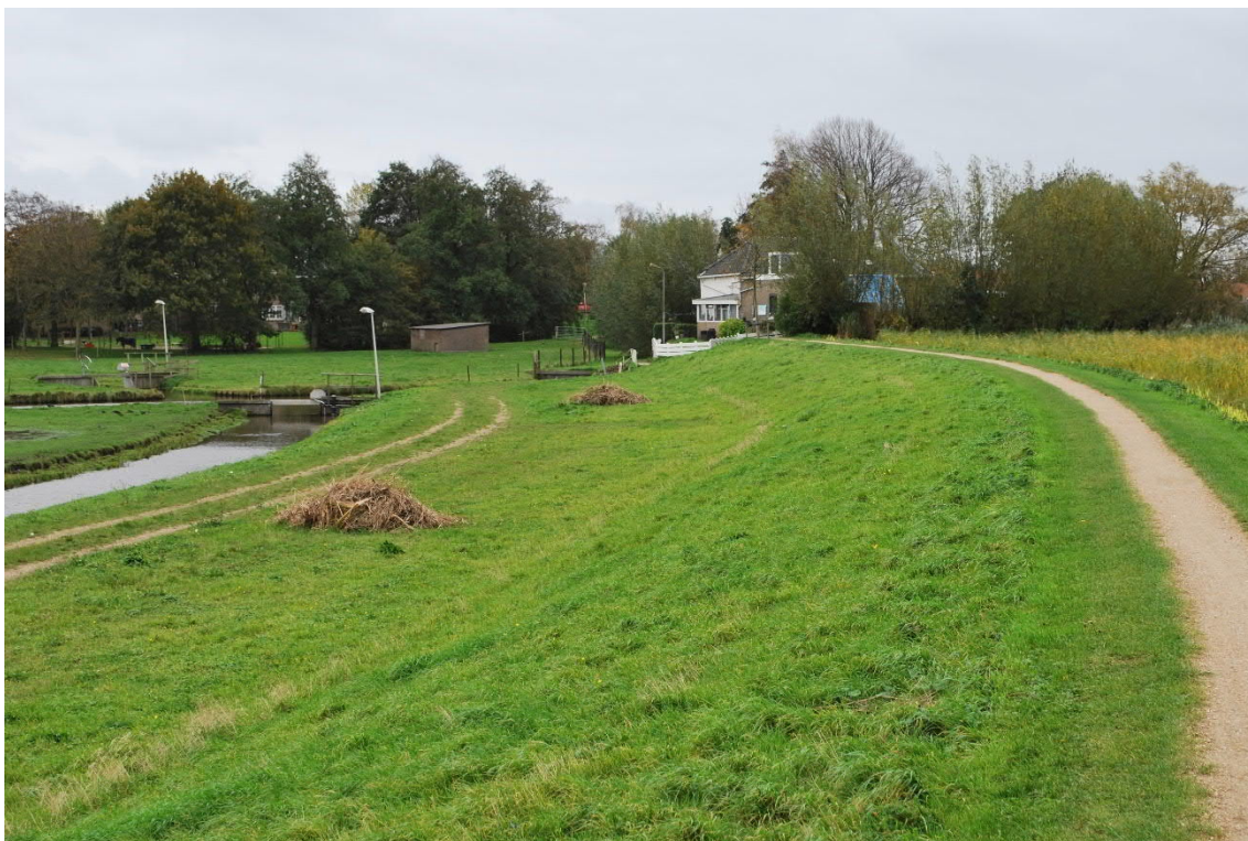
Foto 1: Overzichtsfoto locatie 1: laag gelegen terrein tussen Commandeurskade (rechts) en poldersloot (links)
