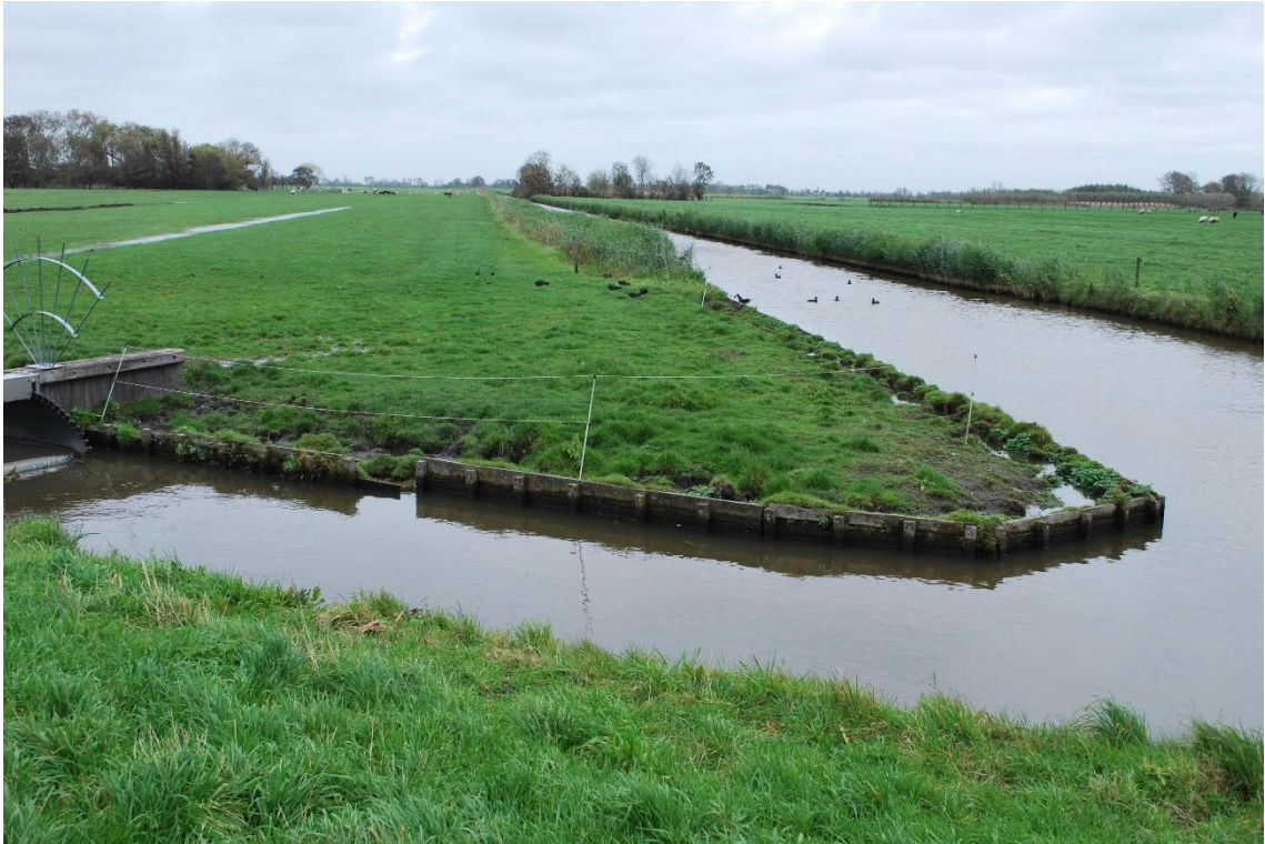
Foto 3: houten beschoeiing poldersloten benedenstrooms van stuw
