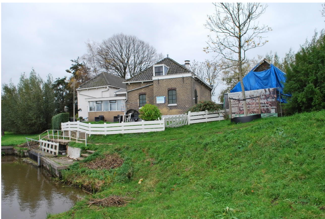
Foto 6: Bestaand gemaal op de Commandeurskade met woning (links) en bakhuisje (rechts)
