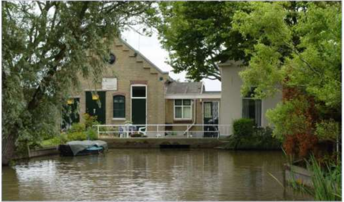
Het gemaal van de Commandeurspolder aan de Zuidgaag
