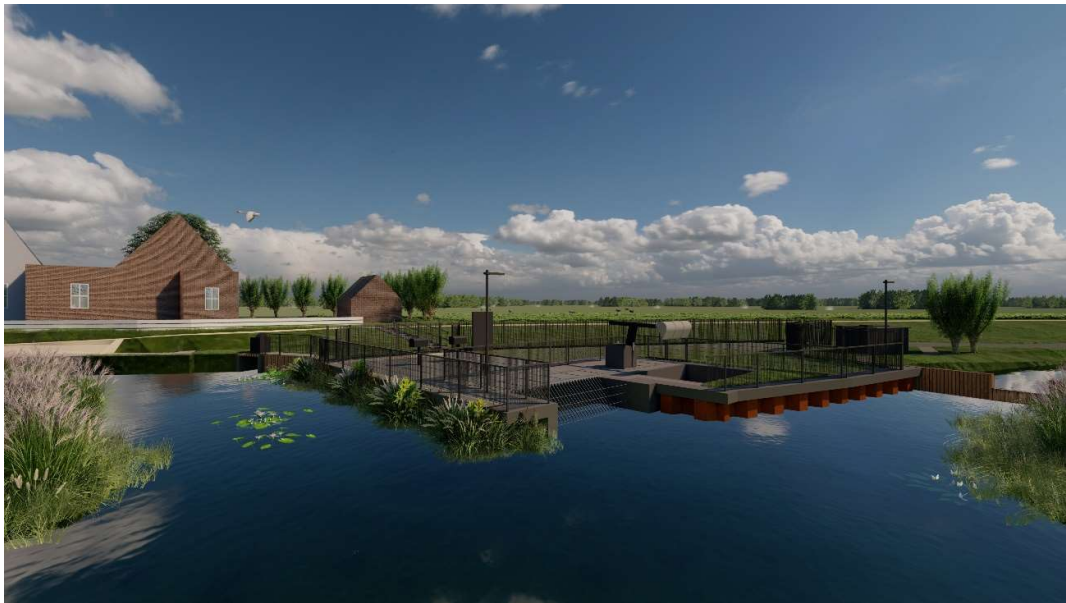
Zicht vanaf het water op het gemaal
