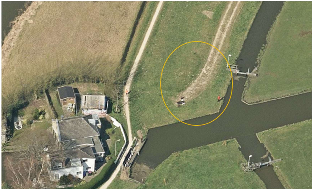
Locatie ondergronds gemaal gezien richting noorden
