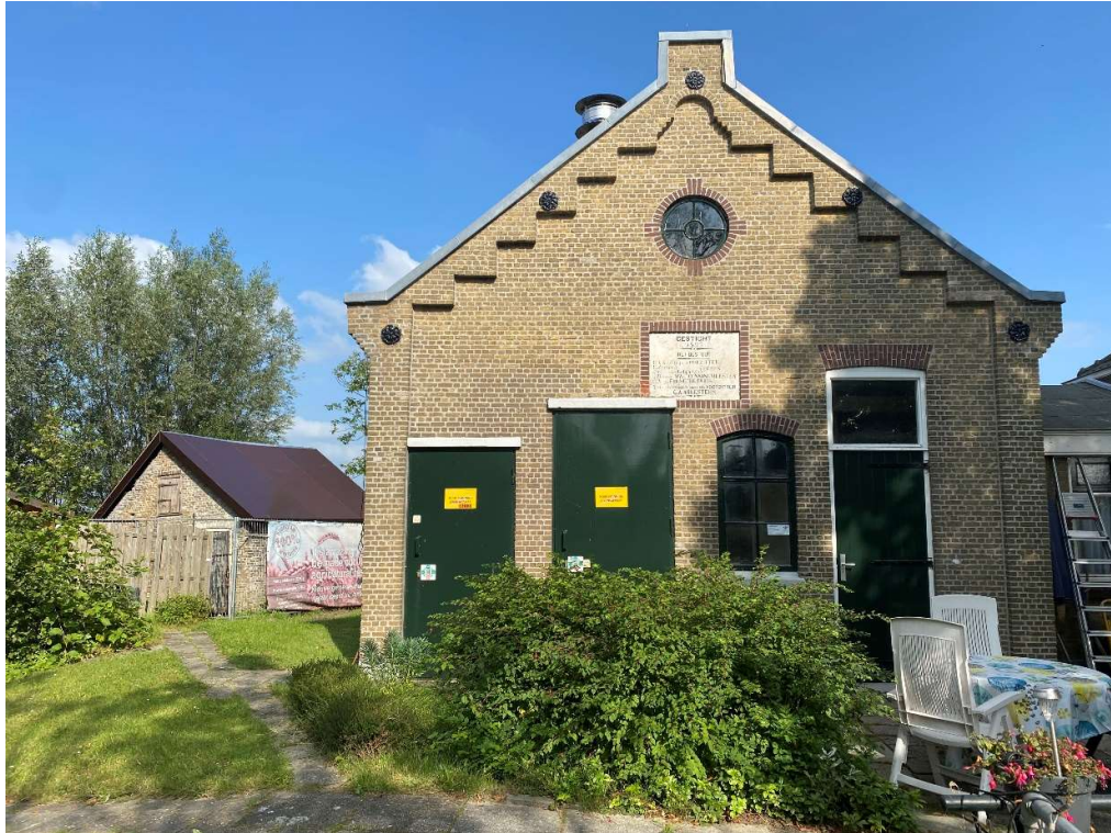
Het gemaal van de Commandeurspolder aan de Zuidgaag met het bakhuisje op de achtergrond.
