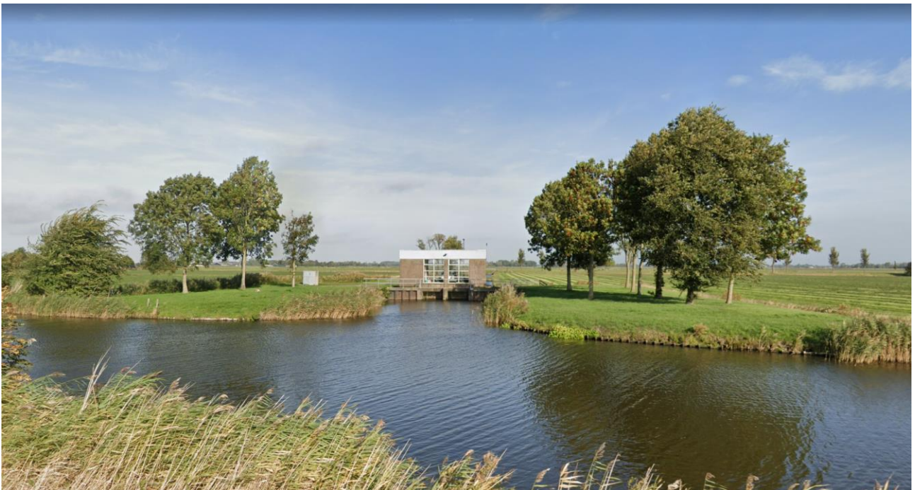
Figuur 3: Foto gemaal Sichterman vanaf de zuidzijde over het Winsummerdiep
