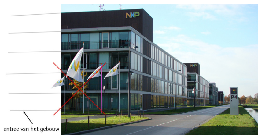
Niet akkoord: geen uniformiteit in afmeting van de mast, de vlag en in de kleur van de mast
