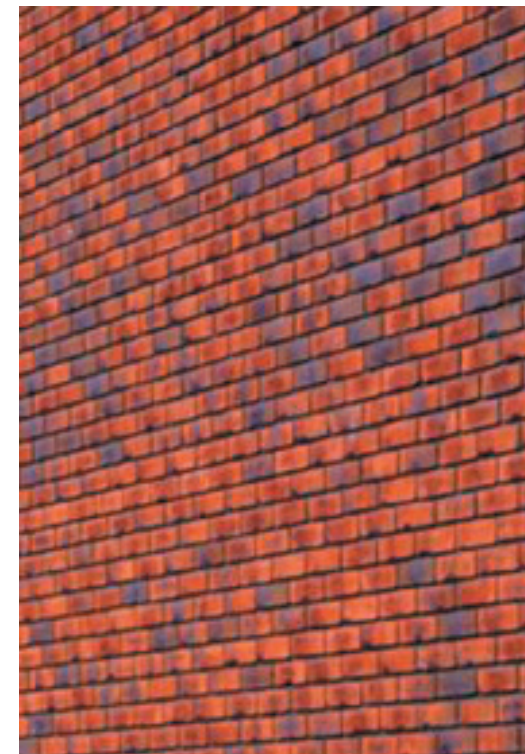
rood metselwerk met voeg verdiept
