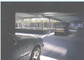
daglichttoetreding in parkeergarage d.m.v vides of gedeeltelijk open gevel
