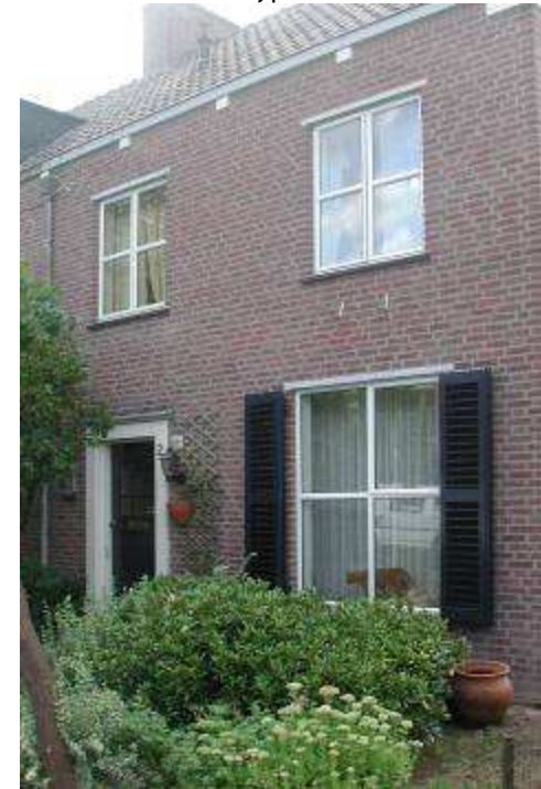
stalen ramen vervangen door aluminium
