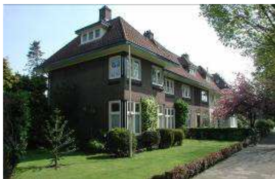
Huygenslaan-arch. G. Geenen
