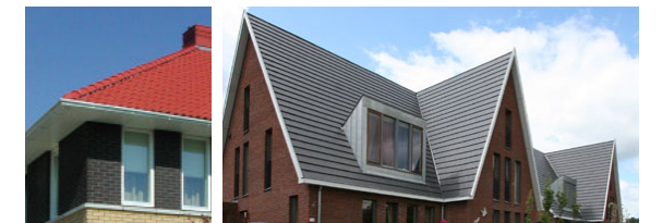
Detail goot als voorbeeld (!) Belangrijk zijn de doorgaande lijn en overstekende goot.
