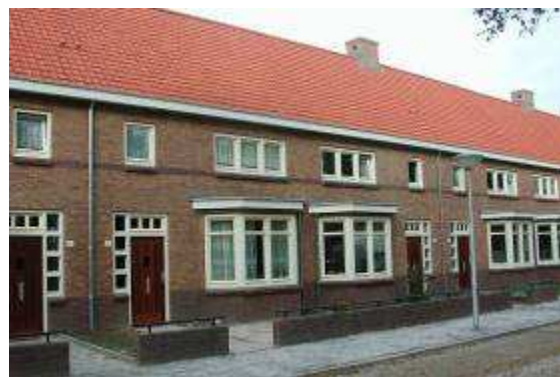
Renovatiewoningen aan Hendrik de Keyzerplein
