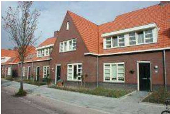
Nieuwbouw, woningtypes K, Kv en G aan de Keldermanstraat
