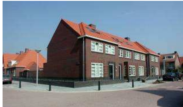
Nieuwbouw, woningtype Vv en Vk, Alard du Hamelstraat
