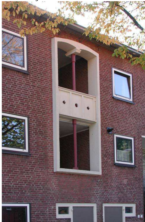
Loggia woningtype J aan de 's Gravensandstraat
