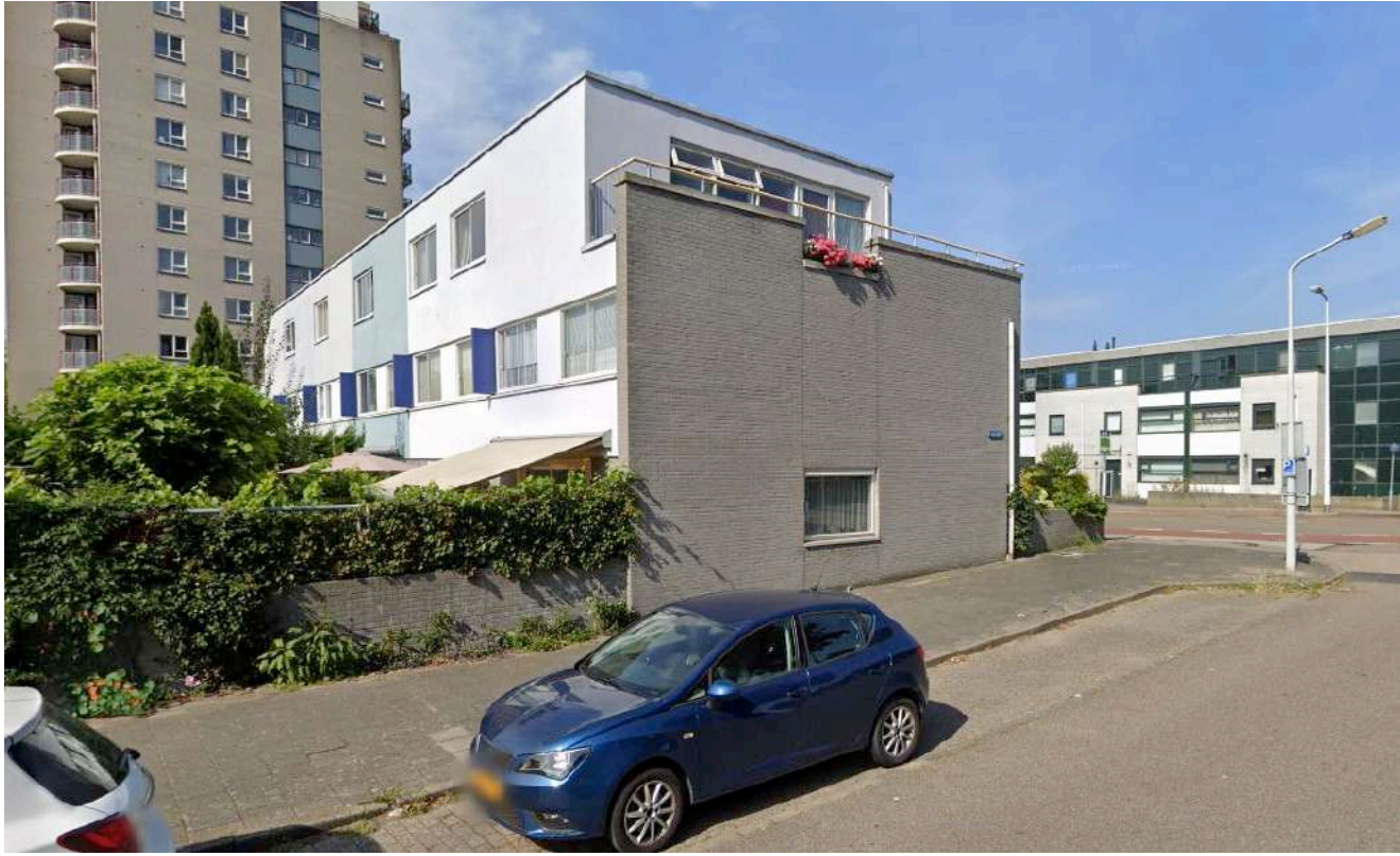
ZIJGEVEL BLOK 1 MET DAK OPBOUWEN
