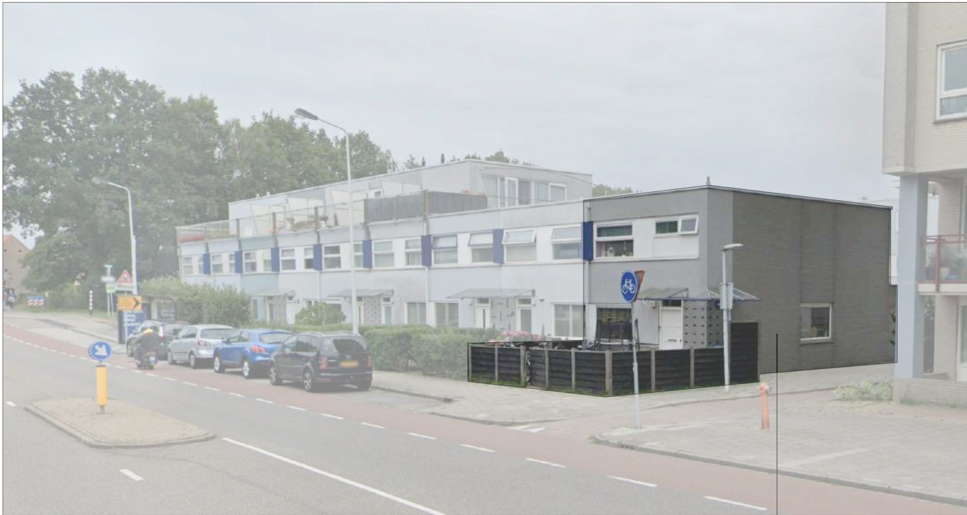
VOORGEVEL BLOK 1 MET DEELS DAK OPBOUWEN
