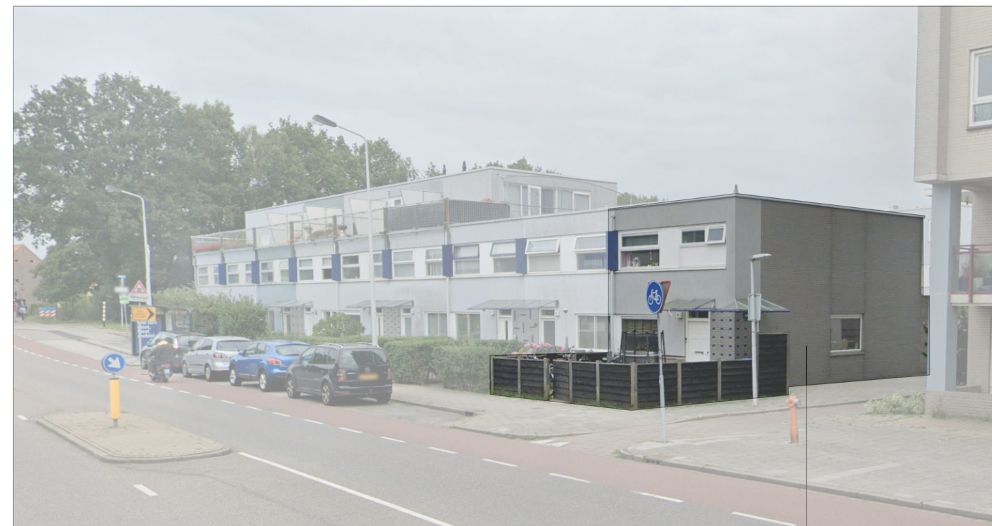
VOORGEVEL BLOK 1 MET DEELS DAK OPBOUWEN
