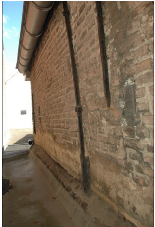
Afb. 32: Door dit gat gezien, de borstwering aan de buitenkant naar achter. Merk de bouwsporen en de diverse ankers op.
