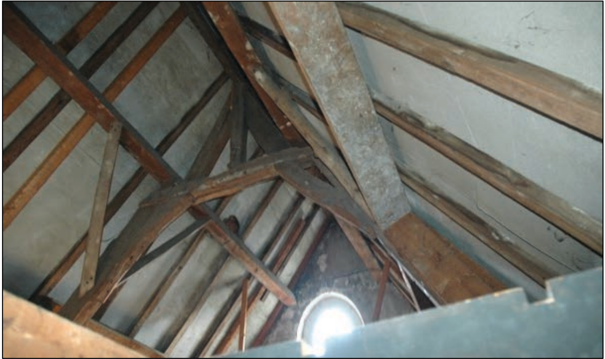
Afb. 55 [B]: De kap van het voorhuis richting voorgevel.
