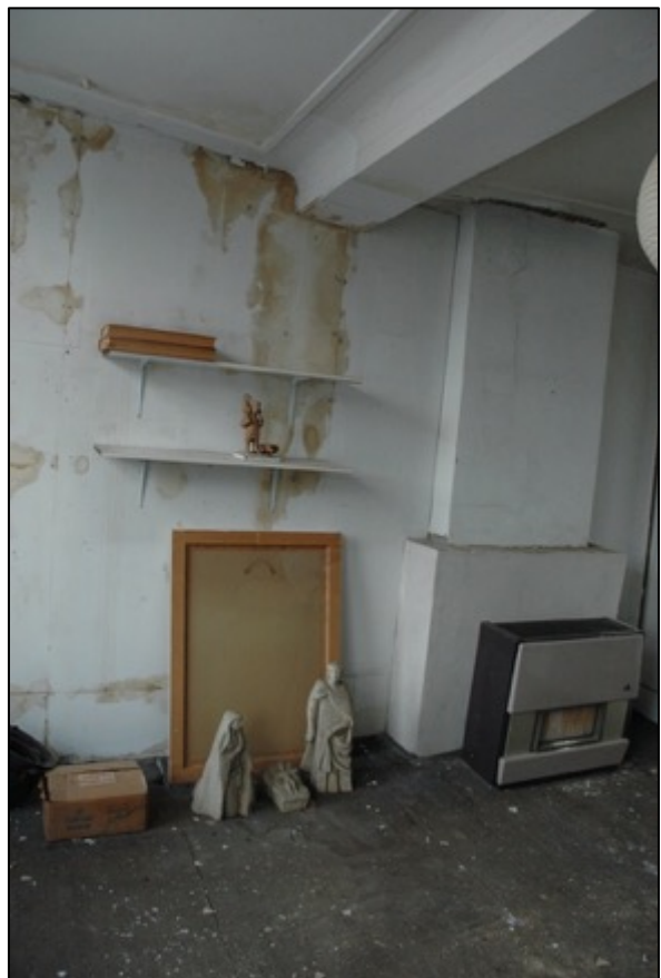
Afb. 69: De achterkamer op de verdieping van het achterhuis naar rechts. In het gestuukte plafond is een ingepakte moerbalk opgenomen.
