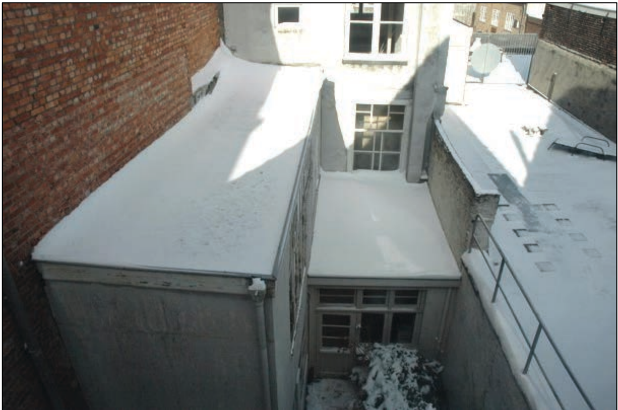
Afb. 26: Gedeelten van de midden- en achterbouwen. Links de verdieping van het tussenlid, rechts het achterhuis met de lage aanbouw uit de jaren dertig.
