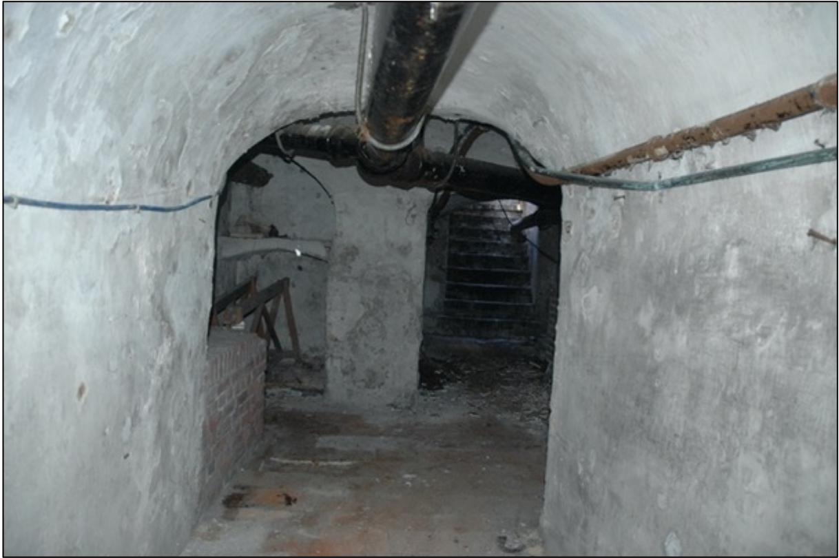
Afb. 36: Keldercomplex, gefotografeerd naar achter, richting de entree onder de achtergevel van het voorhuis.
