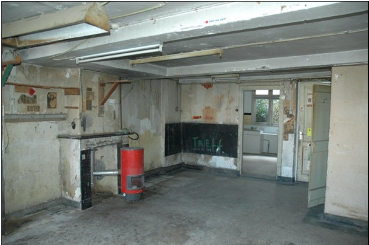
Afb. 65: De voormalige werkplaats op de begane grond van het eigenlijke achterhuis, gezien naar voor.
