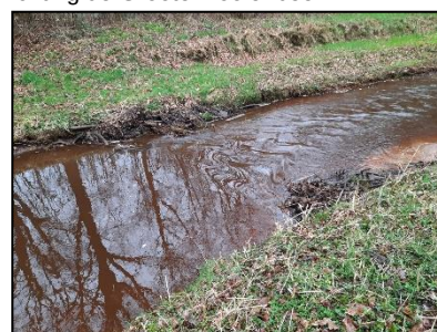
Figuur 16. Doorgebroken dam ter hoogte van Kabroekse Beek.
