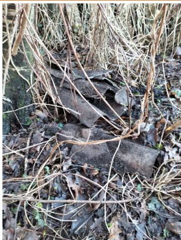
1. Asbestplaten op het maaiveld (perceel Middelberterweg 5) - 16 januari 2023
