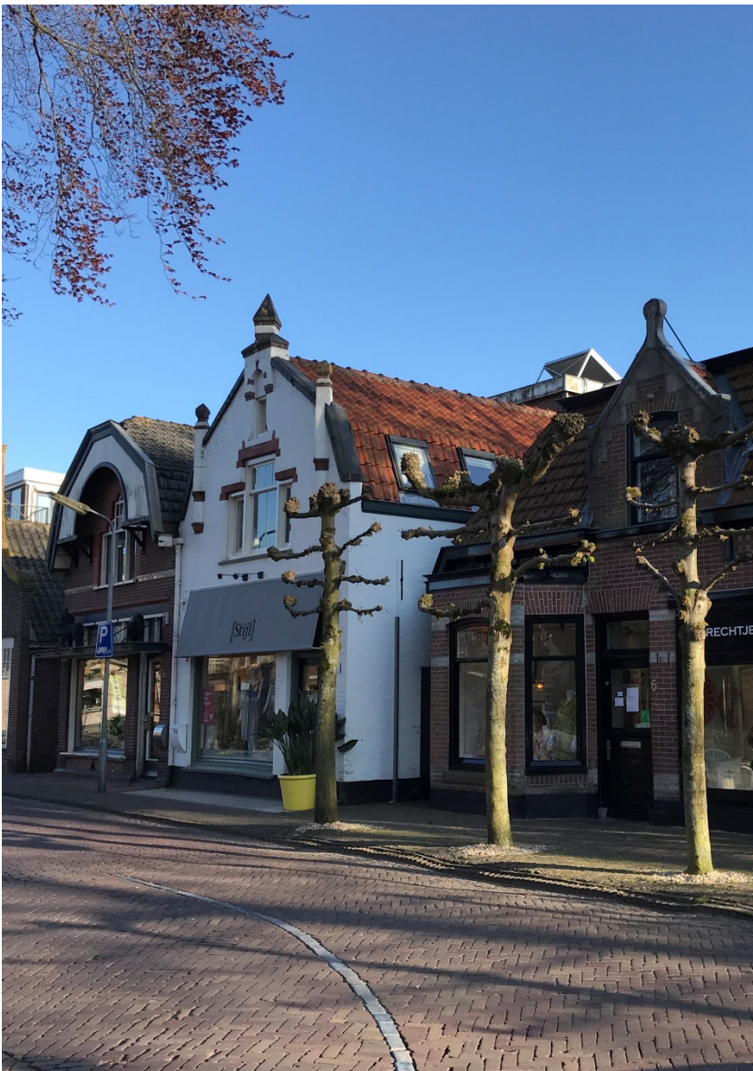
Karakteristieke dorpsbebouwing in beschermd dorpsgezicht Bergen
