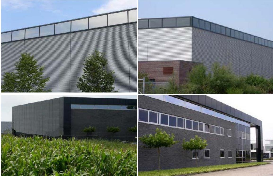
Dakranden van verschillende afmetingen, materialen en met veel verschillende functies.
