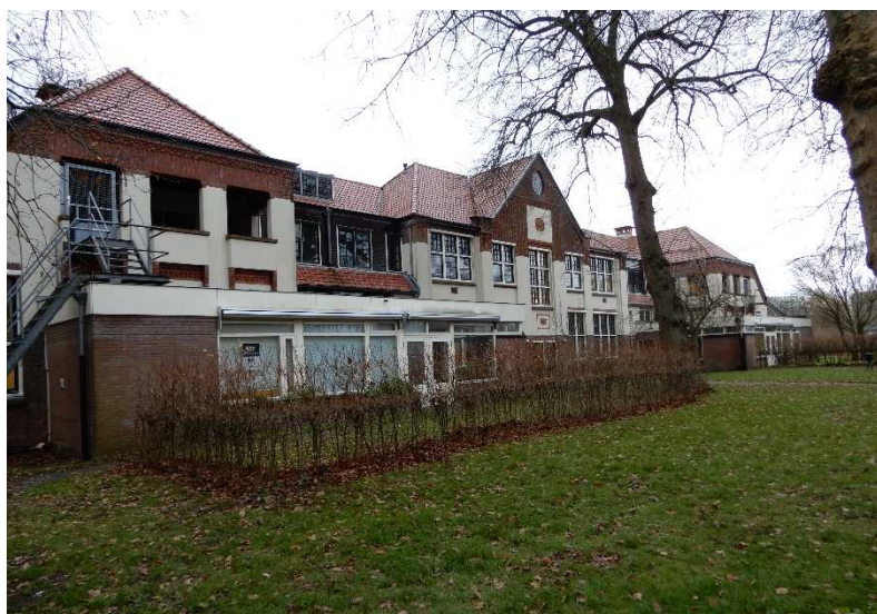
Foto 1 Huidige situatie met twee grote aanbouwen, beide zullen gesloopt worden
