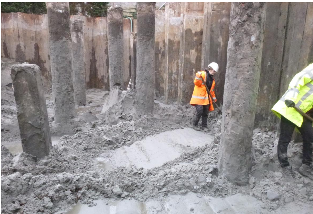
Figuur 6. Aanleg vlak 2.
