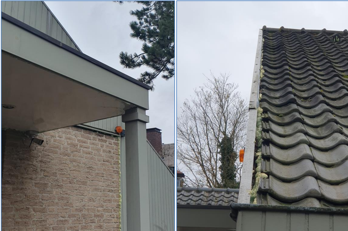
Figuur 7: Kieren zijn met purschuim gevuld
