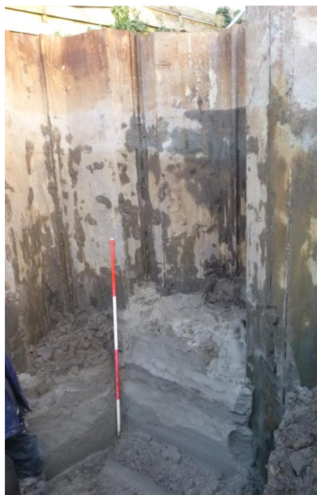
Figuur 8. Ontgraving van het natuurlijke zand tot de maximale ontgravingsdiepte in de noordoostelijke hoek van het plangebied.
