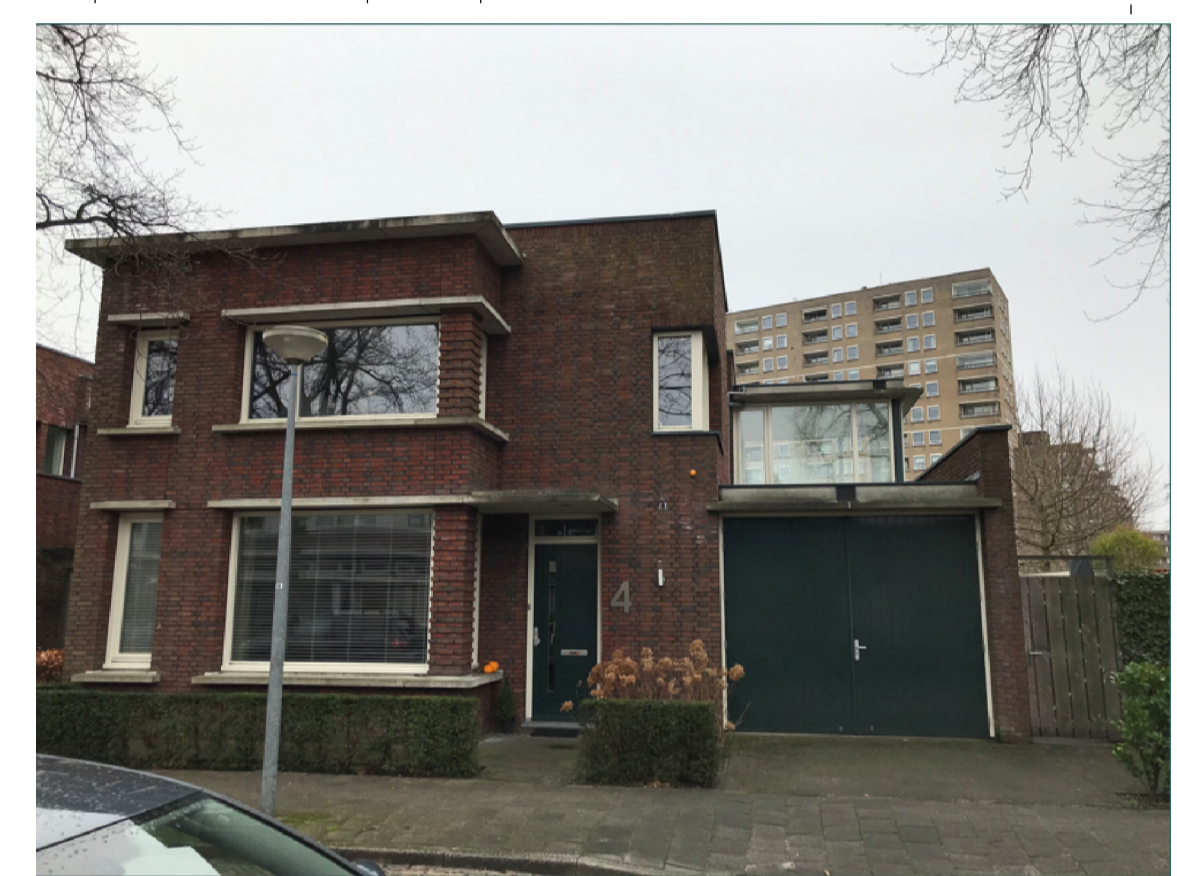
FOTO 1: Voorgevel -ZuidWest- Wijtenbachweg 4
