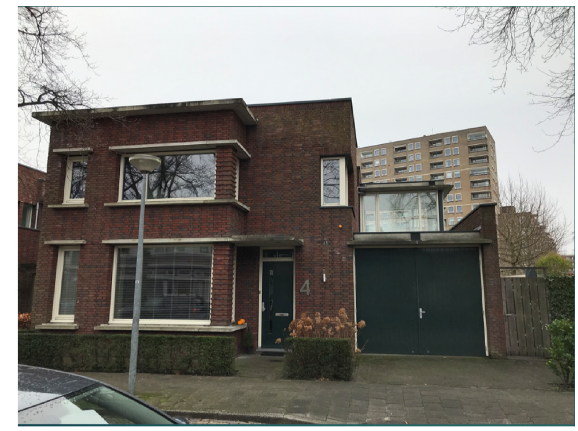
FOTO 1: Voorgevel -ZuidWest- Wijtenbachweg 4
