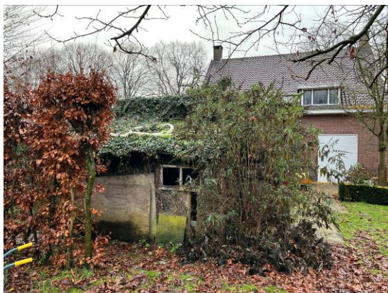
Open schuurtje / aanbouw, dakpannen dak
