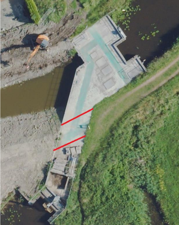
Figuur 14. Locatie betonnen keerwanden op het gemaal (bron Street Smart, Cyclomedia, d.d. november 2022)
