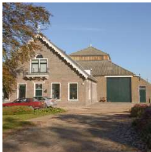
Principeschema met voorbeeld van een Haarlemmermeerse boerderij in Haarlemmeer. Hier is het opgetilde dak van de schuur goed te zien. (Kathrin Vierveijzer)
