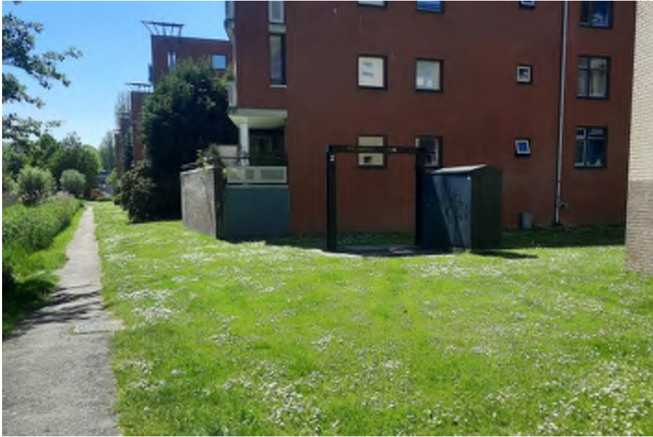
Afbeelding 5: foto gemaal Schuttersveld
