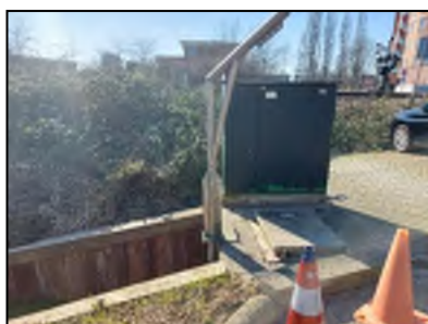
Figuur 9. Overzichtsfoto van het gemaal Teldersekade te Leiden.
