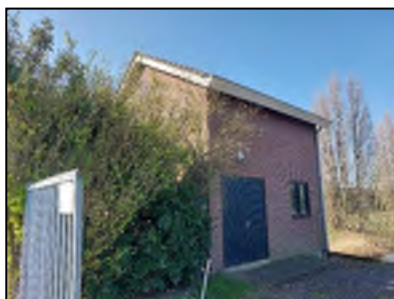
Figuur 16. Het aanwezige gebouw met overhangende kantpannen op de onderzoekslocatie te Velsen-Zuid.
