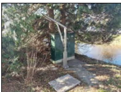
Figuur 8. Overzichtsfoto van het gemaal Vollenhovenkade te Leiden.
