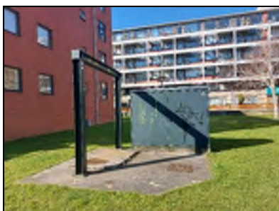
Figuur 5. Overzichtsfoto van het gemaal Schuttersveld te Leiden.
