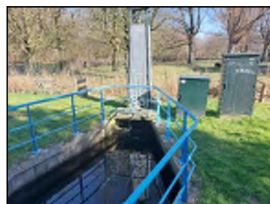
Figuur 10. Overzichtsfoto van het gemaal Wijkpark te Leiden.
