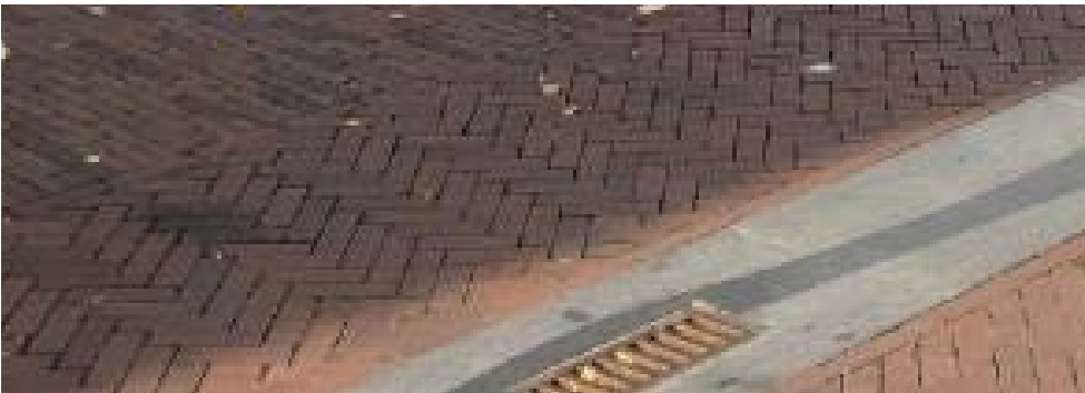
Hardstenen goot in de Haspelsestraat
