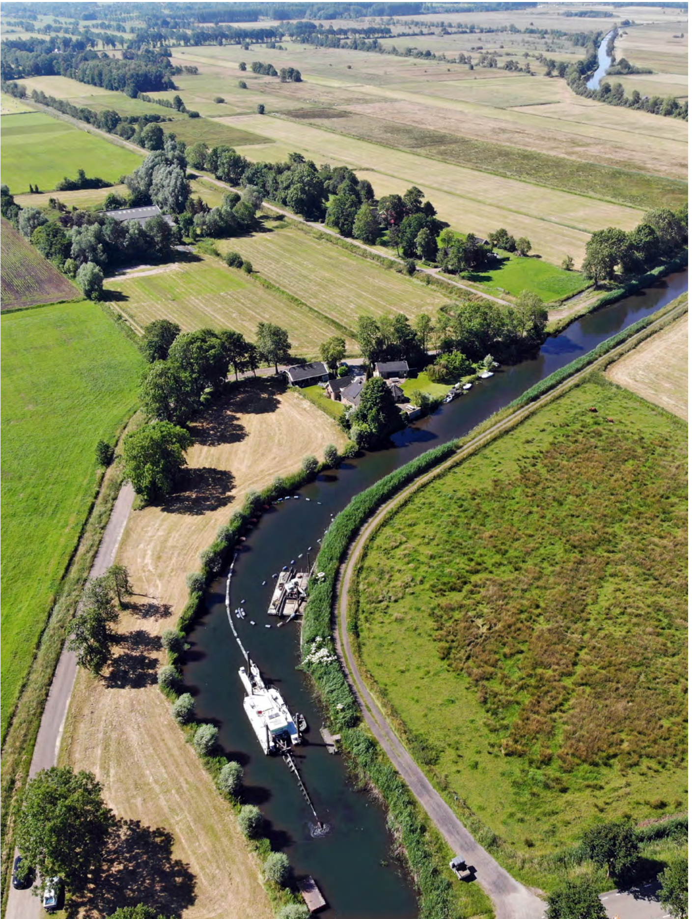
Het baggeren van het Dwarsdiep met een cutterzuiger
