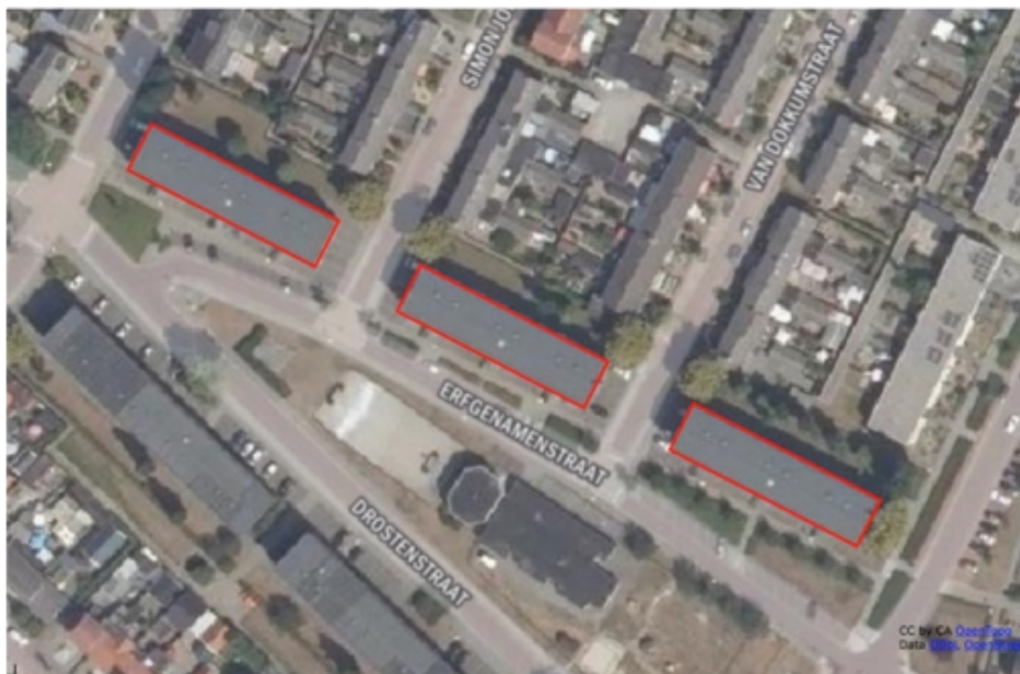
Figuur 1. Plangebied met te slopen portiekflats.
