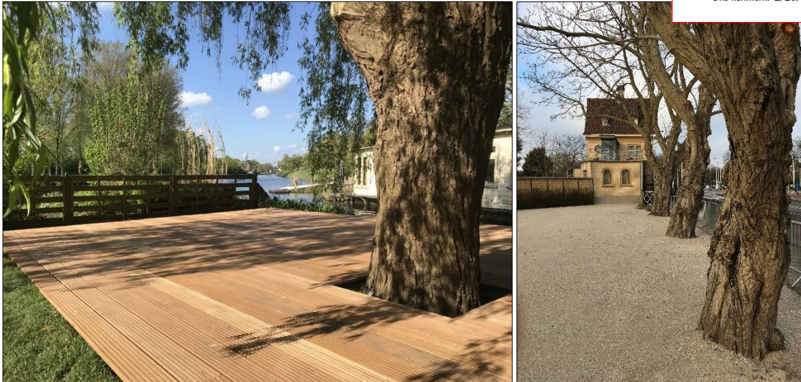
Een voorbeeld van het toepassen van een houten vlonder rond de stamvoet van een boom (links) en stabilizer verharding (rechts).
