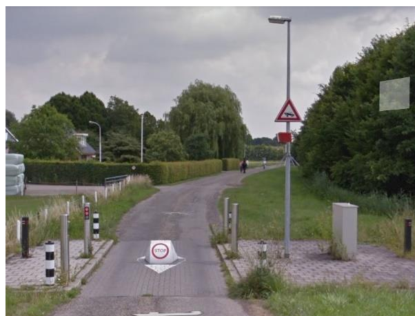
Figuur 57: Voorbeeld afsluiting, toegang voor bewoners; Loostraat/Huissensedijk. Bron: Google Streetview
