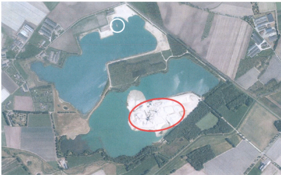
Ligging verwerkingsinstallatie (rode cirkel) en zuiger (witte cirkel) bij huidige ontgrondingslocatie De Diepeling
