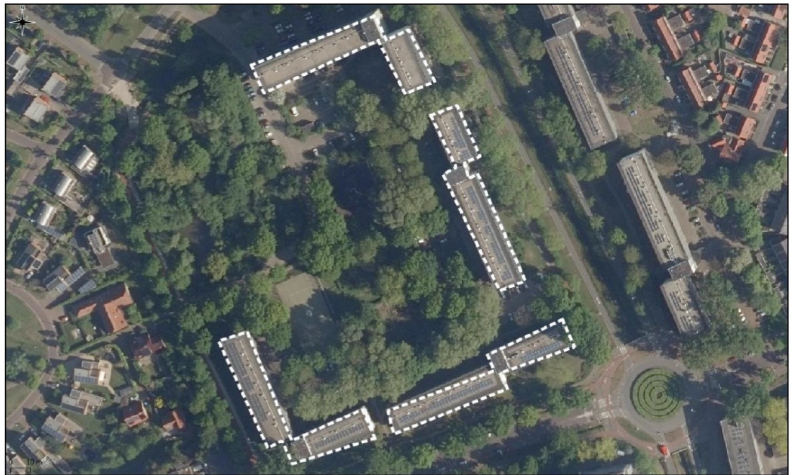
Figuur 2. Aanduiding van de vier te renoveren appartementencomplexen aan de Pomona 1-119 & 2-560 te Wageningen.
