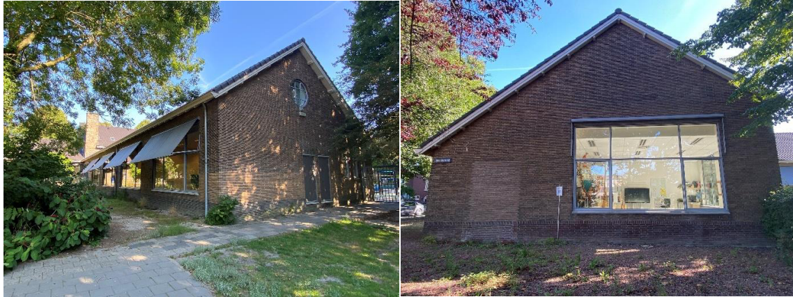
27 en 28 – De rechterzijgevel van bouwdeel C en de rechterzijgevel van bouwdeel E.
