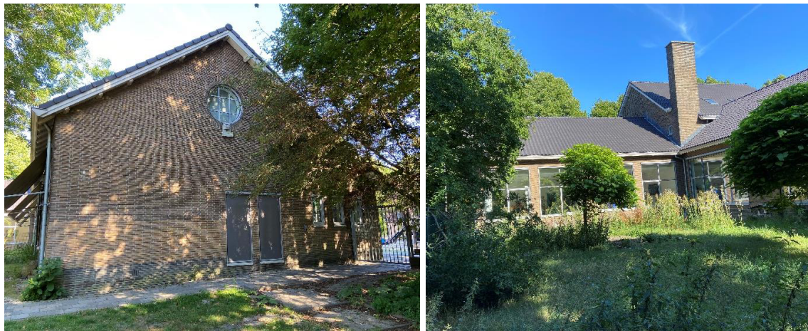
25 en 26 – De achtergevel van bouwdeel C en bouwdeel E.
