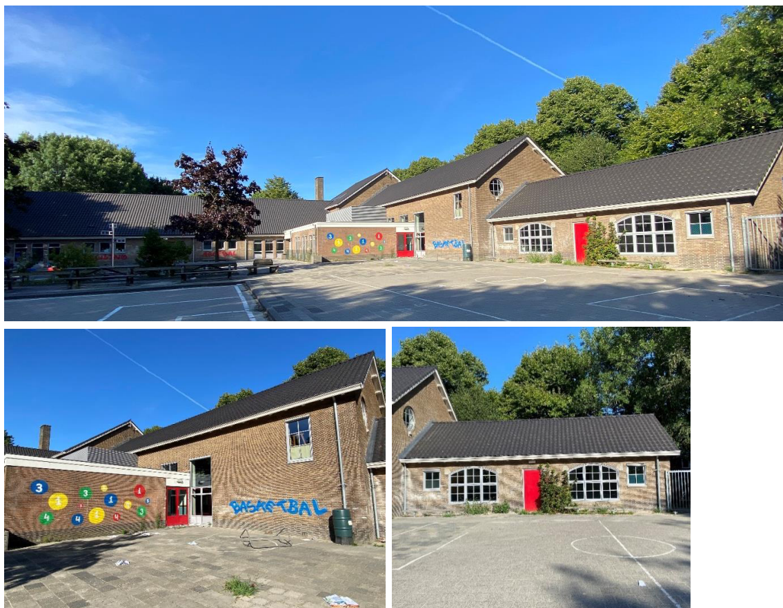
22 t/m 24 – De achtergevel van de bouwdeel B en D.
