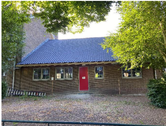
17 t/m 19: Met de klok mee: voorgevel bouwdeel B, D en E.
