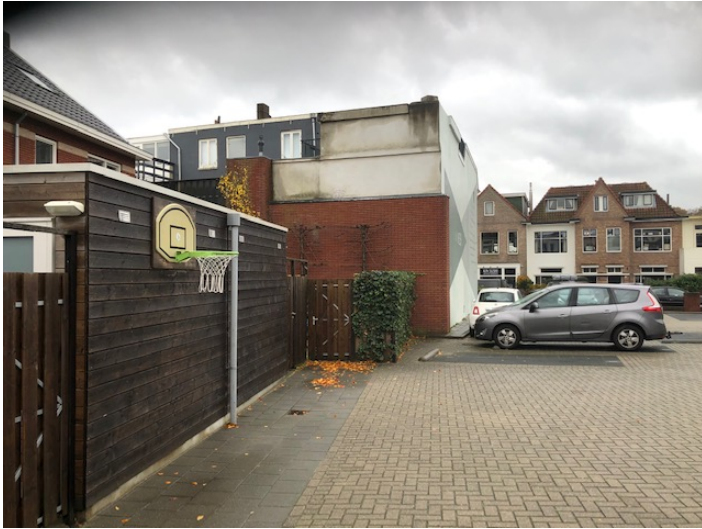
gedeelte achtergevel Deutzstraat 6-8
