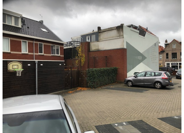
Gedeelte achtergevel Deutzstraat 4-6-8-
