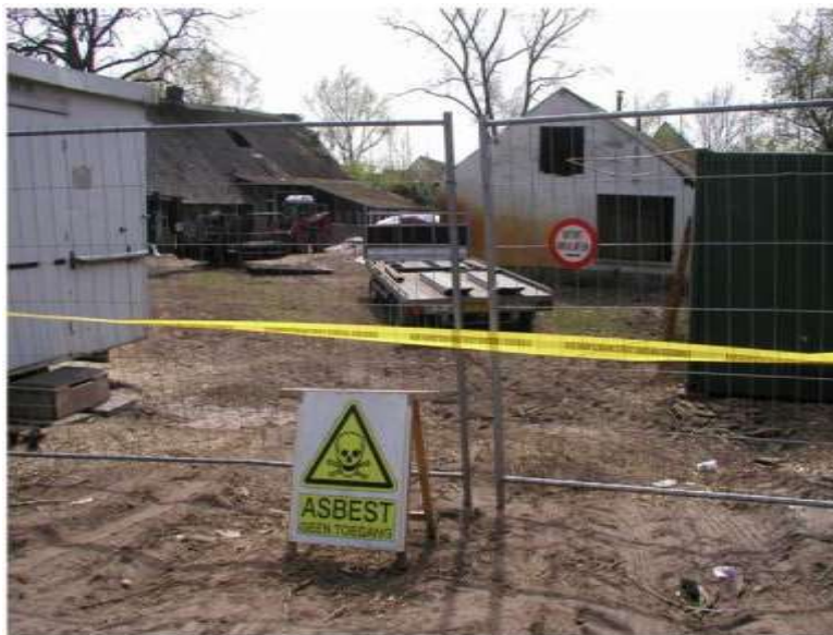
Figuur 4.11: Afscherming van een asbestverdachte locatie
