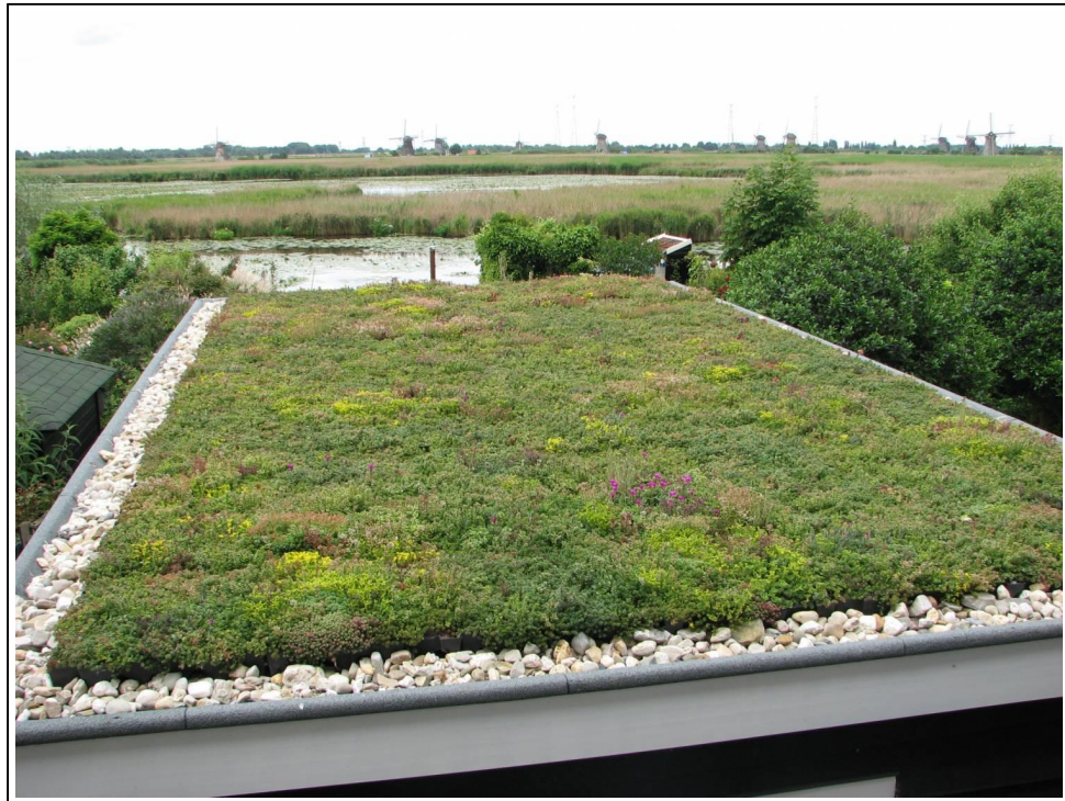
plat dak: dakbedekking met substraat
