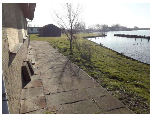
Foto 6: Achterzijde woonhuis met steiger
