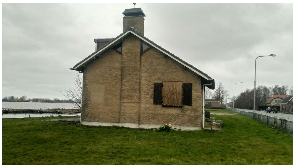
Kopgevel van Geerweg 16 gezien vanuit het oosten. Foto: M. de Vries | Ecoresult B.V.
