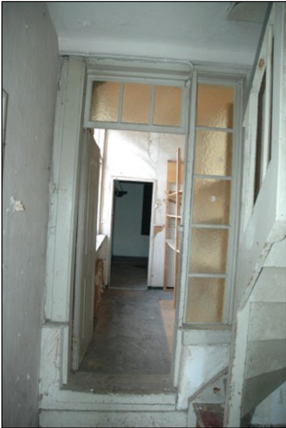
Afb. 67: Vanaf de overloop van het achterhuis, eerste verdieping, in de tweede laag op het verbindingslid gekeken. Hier is een venster tot doorgang met boven- en zijlichten vermaakt.
