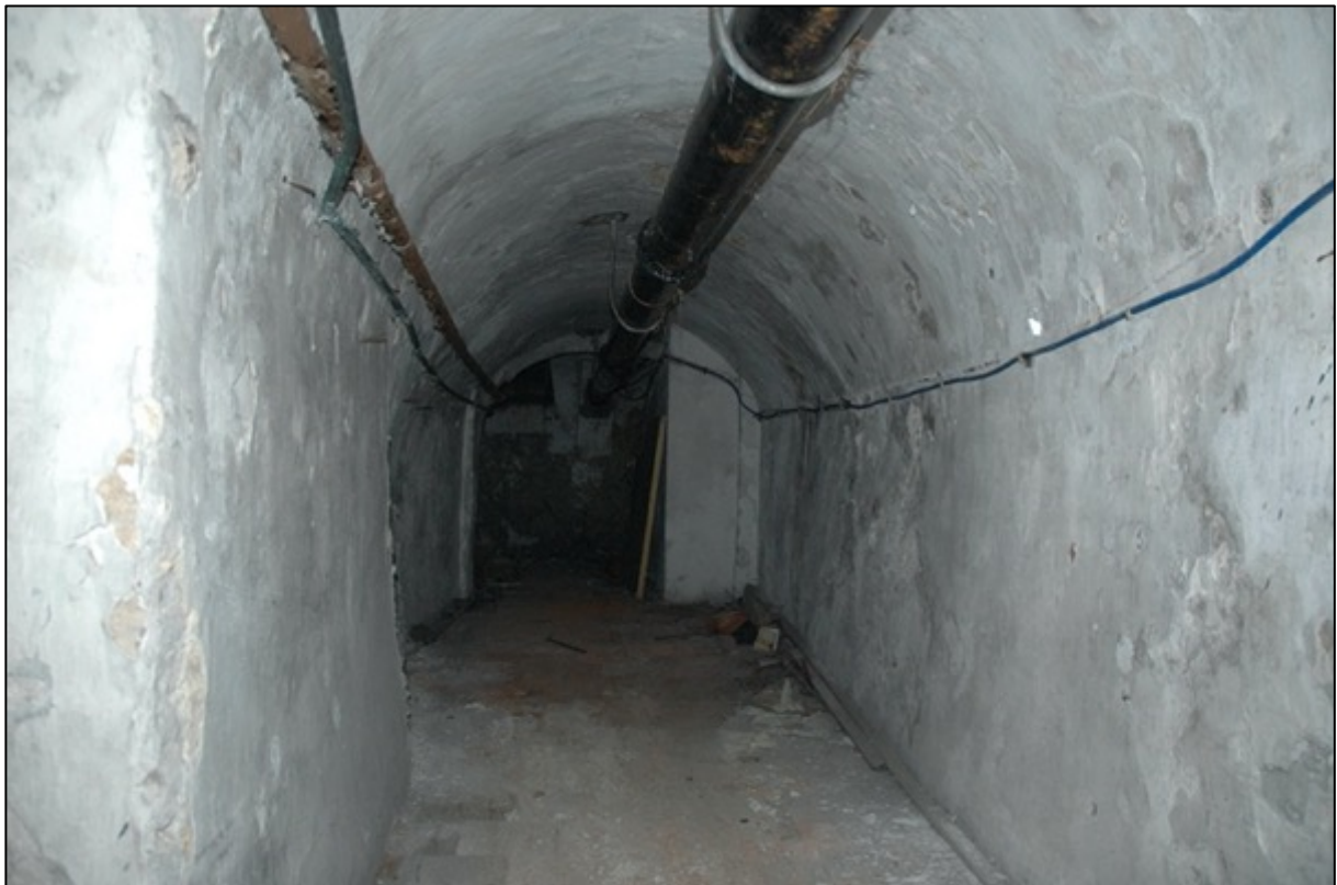
Afb. 37: Kelder, de verbindingsgang richting de voorkamer.
