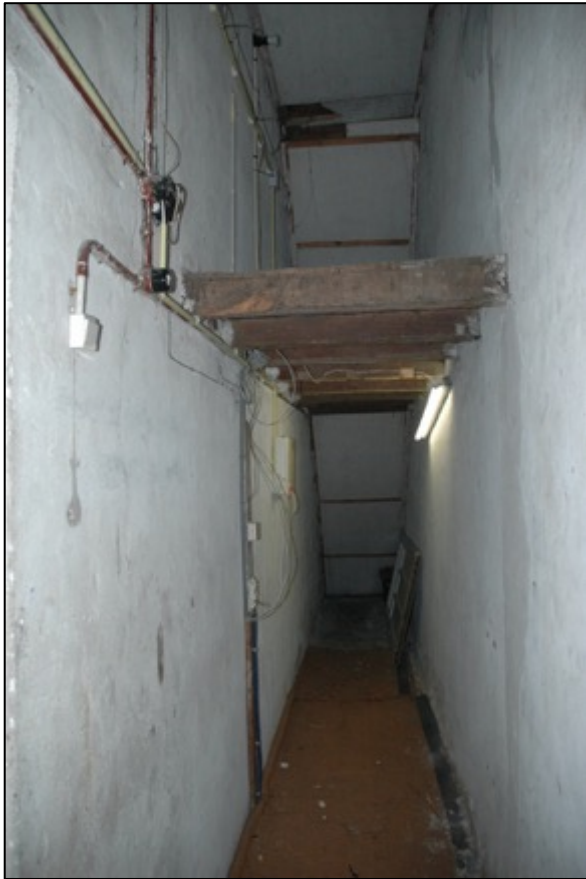
Afb. 41 [LB]: De voormalige buitengang links op de begane grond, naar voor. Met het tussenvloertje van oude vloerdelen op (hergebruikte) kinderbinten.
